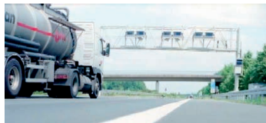
Kontrollbrücke des Mauterhebungssystems auf der Autobahn; Quelle: TollCollect GmbH
